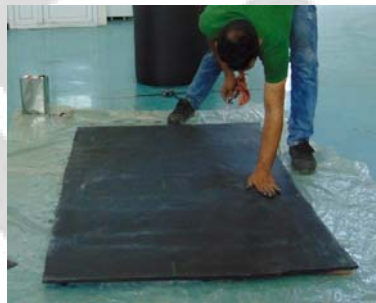
شکل ۱- چسباندن آزمون‌های عایق الاستومری Bellsafe Flex به زیرکار
